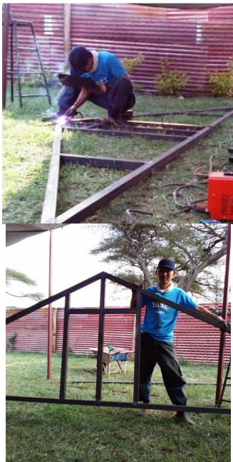
쇠를 자르고 용접해서 지붕이 올라가는 삼각대를 만든 모습
